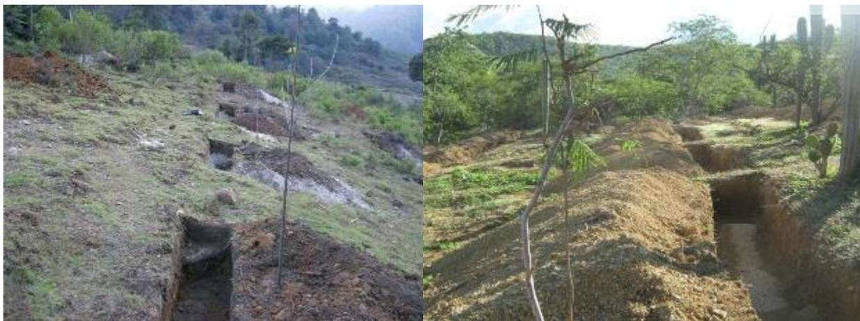
Figura 20. Tinajas ciegas en terrenos de agostadero.
